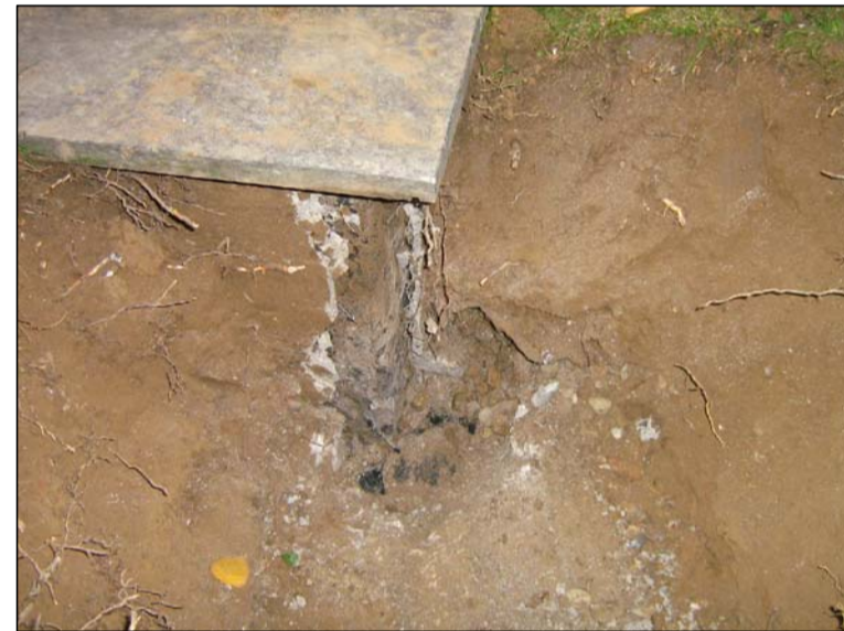
STRATIGRAFIA IN CORRISPONDENZA MURETTO AREAZIONE BOXES
