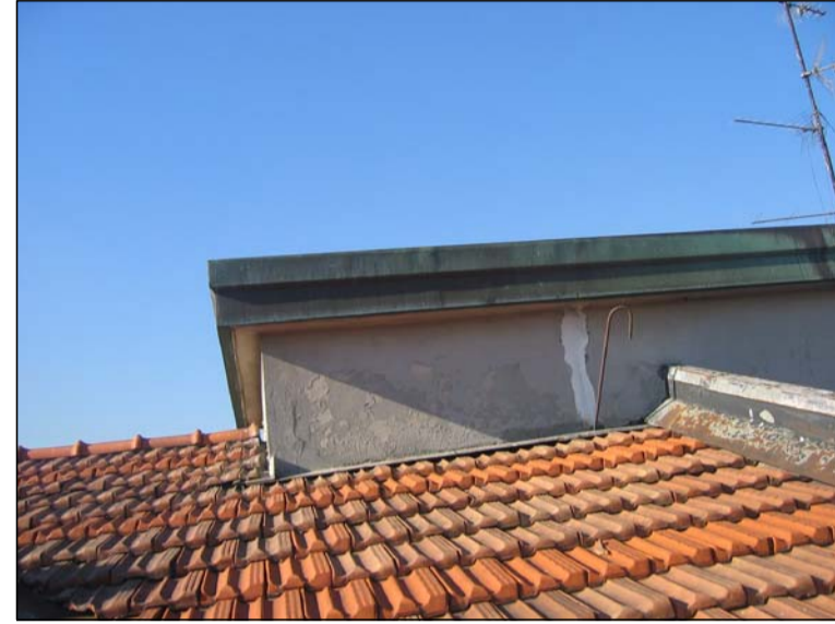
LOCALE TECNICO E VANO SCALA IN COPERTURA
