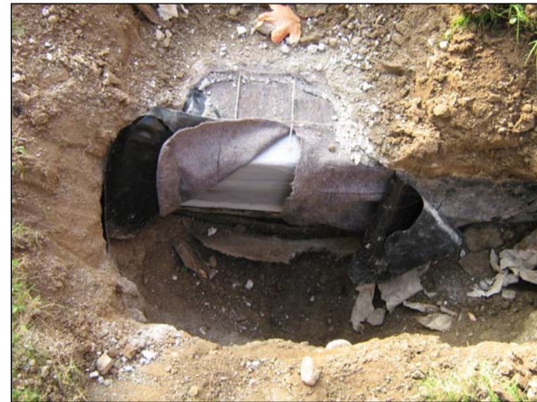
STRATIGRAFIA IN CORRISPONDENZA PERIMETRO STRUTTURA BOXES
